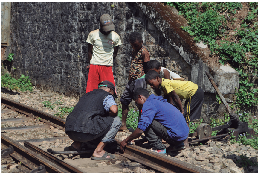
Autosuficients per arreglar la precària infraestructura.
