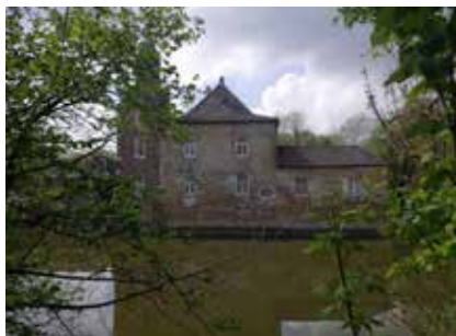
Una extensa zona amb 120 castells de diferents èpoques
